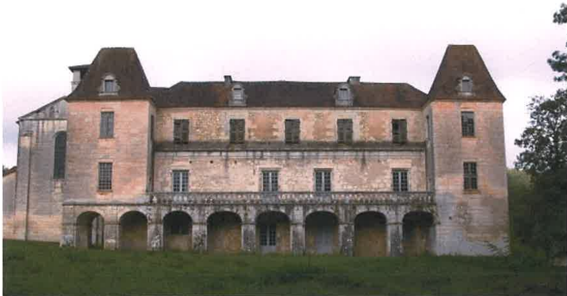
Le logis avant les travaux
